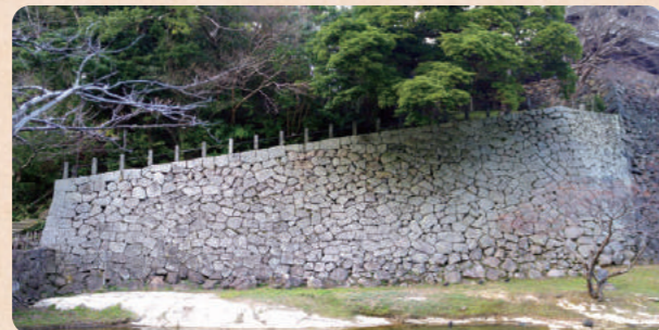
▲切込接 御廊下橋(千鳥橋)北詰石垣
